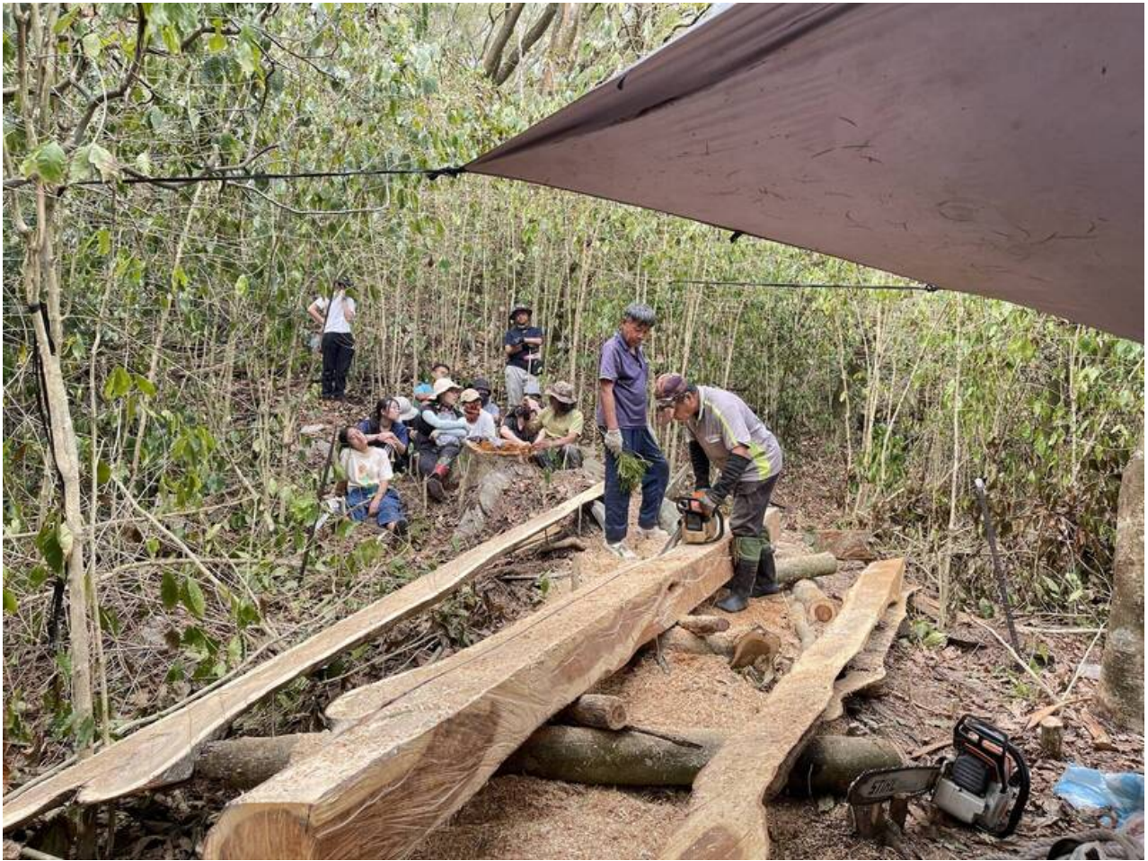
成大考古所師生觀摩家屋樑柱取材、鋸木、去皮、刨木等過程。（成大提供）
