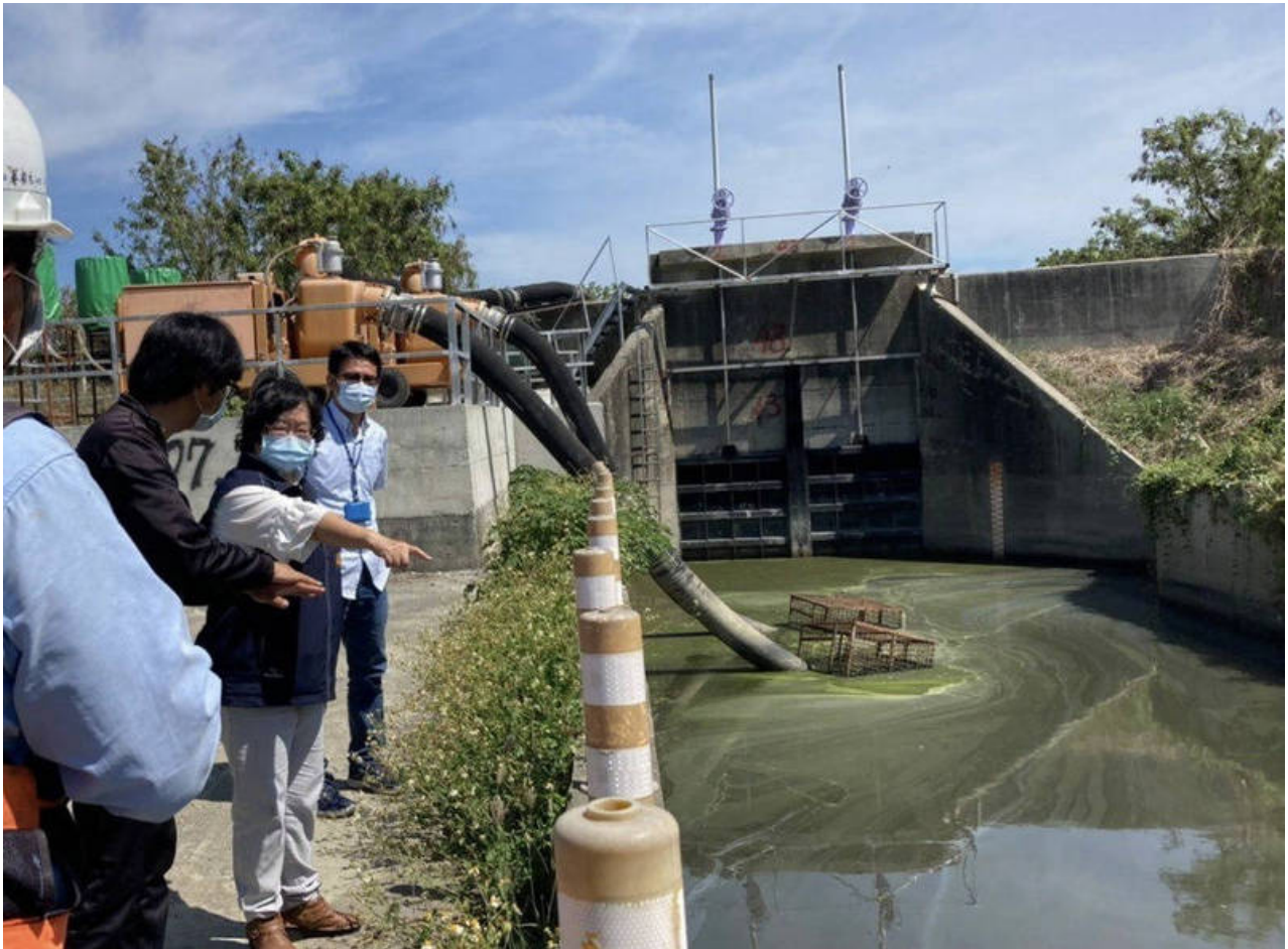
梅雨鋒面報到，南市為防汛整備部署，巡檢抽水站、抽水機、水閘門的運作。（記者楊金城翻攝）
